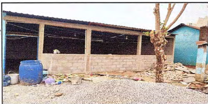
Foto 5: Continuación de pared
