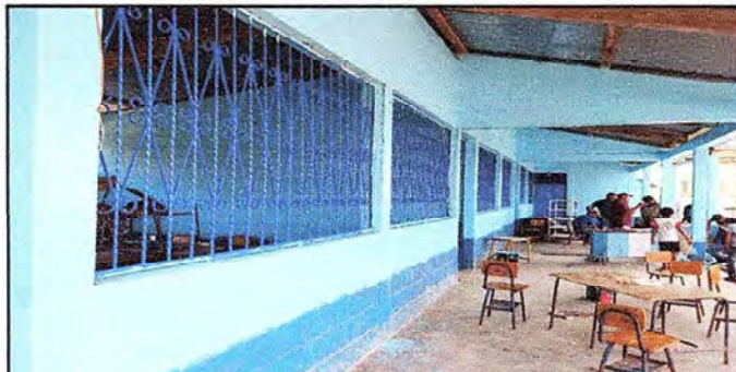
Foto 2: Cambio de balcones
