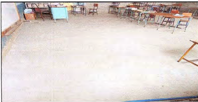
Foto 3: Sustitución de piso
